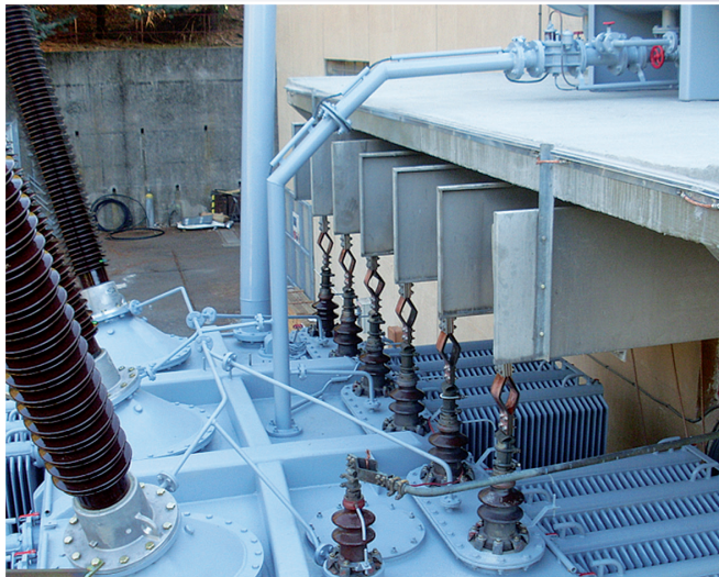
Francia EDF – Central hidráulica de La Figère Rehabilitación TR 40 MVA 225 kV de 1963 2010
