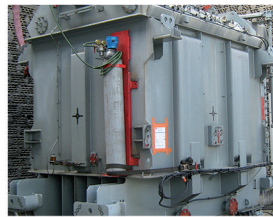
Disassembly and preparation for transport Desmontaje y preparación para el transporte
